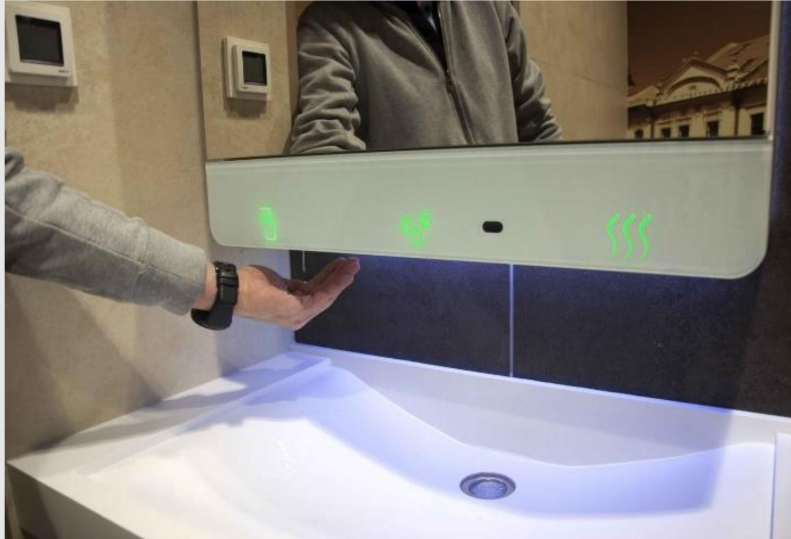
Automatischen Berührungslose Seife Entnahme mit der Möglichkeit der Veränderung der Parameter.
